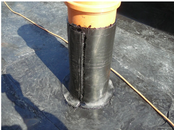
Těsněno Flexobitem do výšky 500 mm
